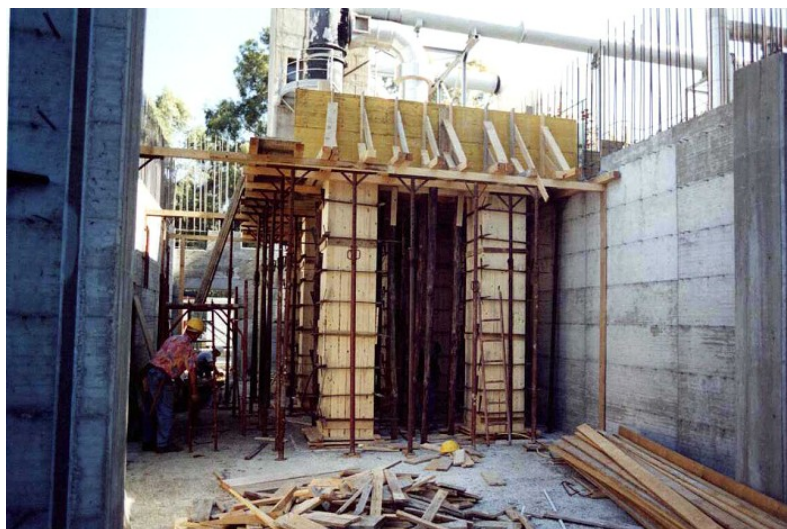
Basamento durante la costruzione
