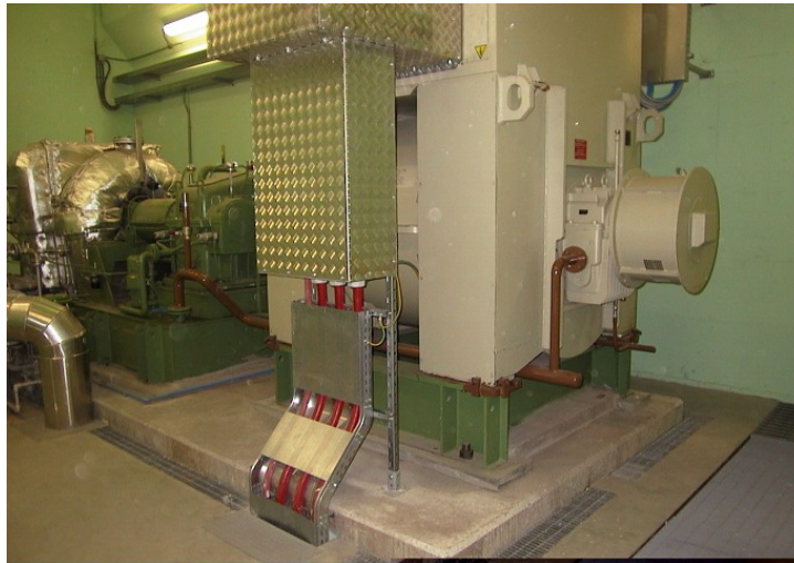
Turbina sul basamento
