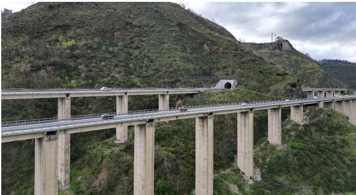
Foto dei due viadotti, in primo piano il Friddizza Nord e in secondo piano il Friddizza SUD
